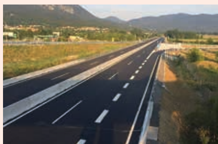
Obnova voziščne konstrukcije HC Vipava – Ajdovščina
