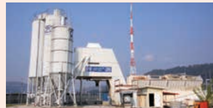
Betonarna Krško (NEK)
