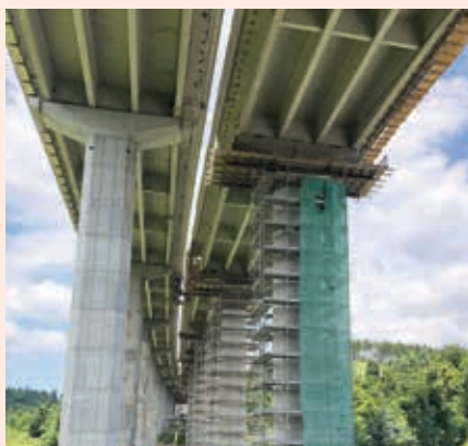
Rekonstrukcija ceste in objektov na AC Unec – Postojna in rehabilitacija viadukta Ravbarkomanda
