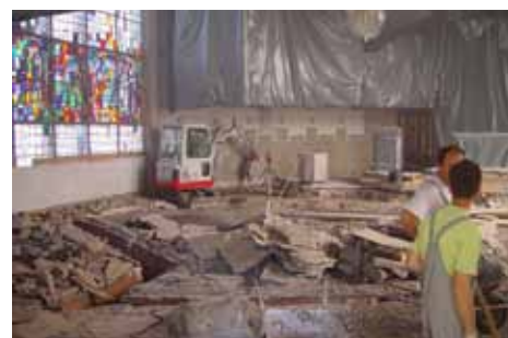
Notranjost cerkve med obnovo
