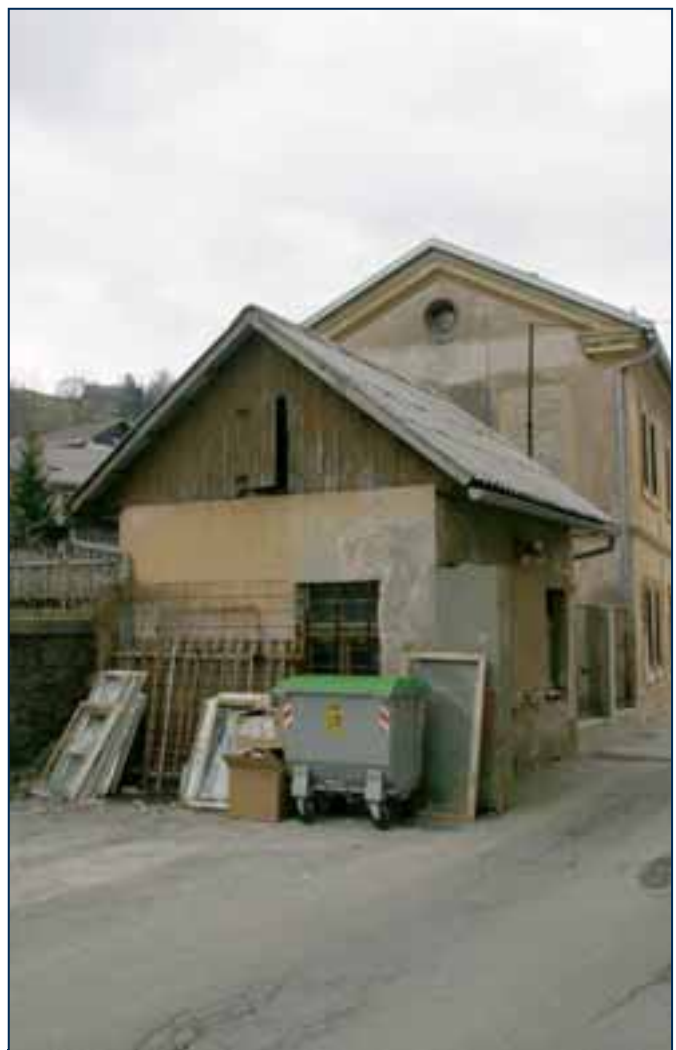
Delavski svet Rudnika živega srebra v zapiranju je že pred več kot dvanajstimi leti sprejel sklep o odstranitvi (rušenju) hišice na Arkovi 43. V njej je rudniška enota civilne zaščite, če ni bil to celo bataljon, hranila svojo opremo. Zdaj, ko objekta pravzaprav ne uporabljajo več, kot vse preostalo rudniško premoženje pa je postal državna last, morda računajo, da bodo z njim še kaj zaslužili. Idričani morajo namreč od države znova odkupiti vse, kar je rudniškega, tisto, kar jim ta brezplačno odstopi, pa je potrebno popravila.
