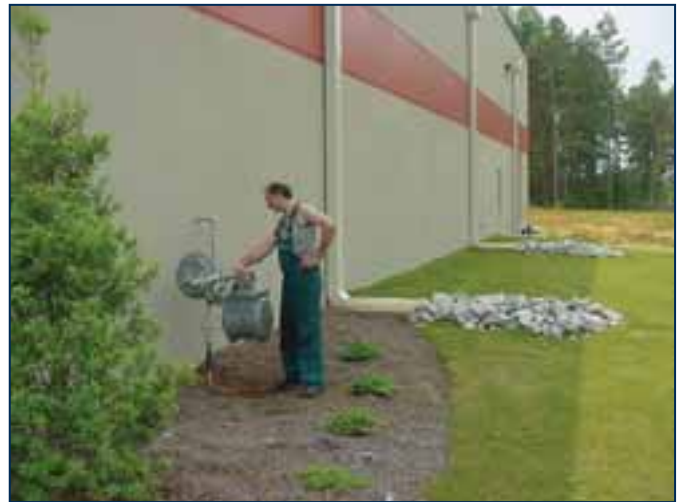
Kontrola plinskega priključka v tovarni TKI Inc. v ameriški zvezni državi Južna Karolina.
