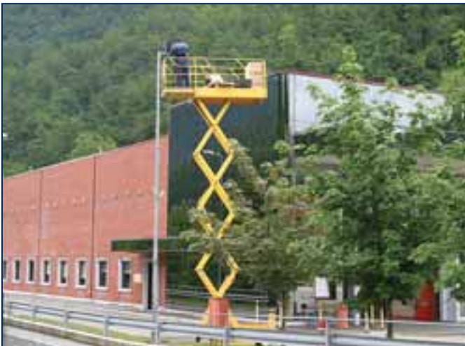
Zamenjava svetil na javni razsvetljavi v idrijski Kolektorjevi industrijski coni.
