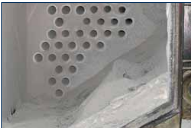
Vzdrževanje je minimalno, ker pri tovrstnih sistemih ne uporabljajo šamotnih kurišč, gorilnik pa je izdelan iz odpornih ognjevzdržnih materialov. O visokih izkoristkih biomase pričča tudi minimalna količina pepela
