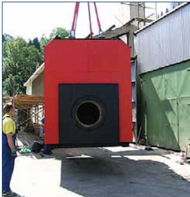
Če že ni največji, pa je kotel gotovo najtežji del nove Celesove kotlovnice na lesno biomaso
