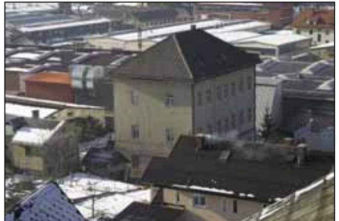
Poslopje na Arkovi 43 je Kolektor že med najetjem preuredil za svoje nove dejavnosti, zdaj pa je za sedemdeset milijonov tolarjev postalo last FMR
