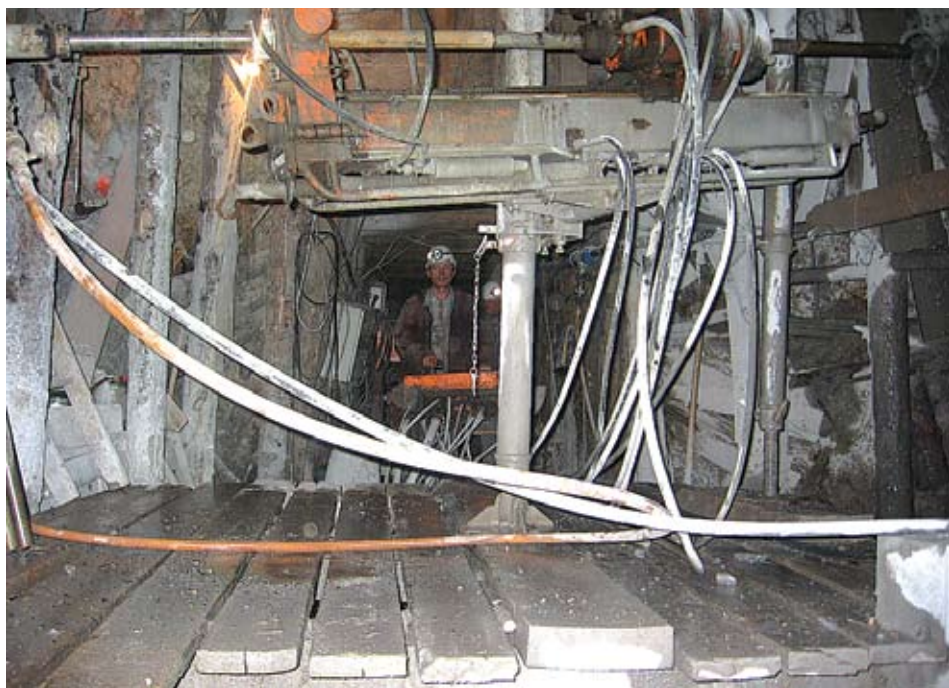
➤ V okviru zapiralnih del je bilo treba izvrtati številne vrtine za injektiranje nedostopnih jamskih praznin
