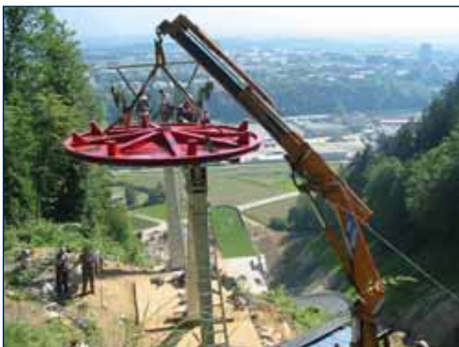
Pomoč pri montaži dvosedežnice ob skakalnici v Kranju
