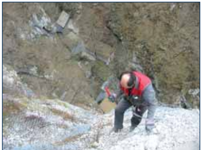
Čiščenje varovalnih mrež v bolnišnici Franja
