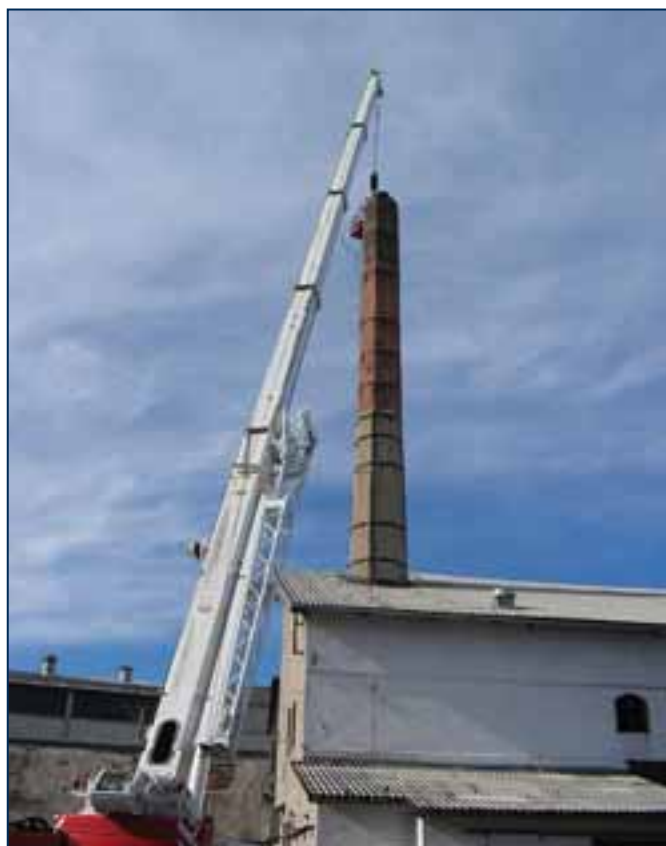
Podiranje 40 metrov visokega dimnika nekdanjega Javorja pod železniško postajo v Postojni
