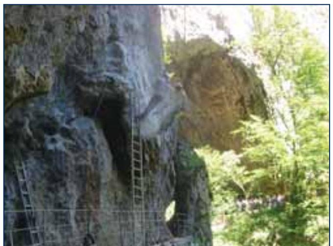
Čiščenje 130 metrov visoke vhodne stene nad izhodom iz škocjanskih jam in sidranje skalnega bloka v matično podlago
