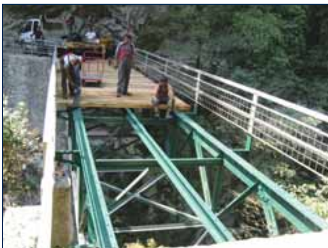
Obnova Hudičevega mostu v Tolminskih koritih
