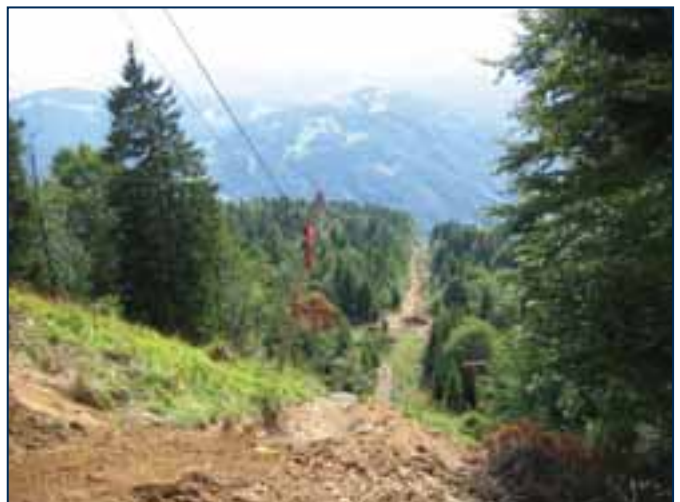
Demontaža dvosedežnice Počivalo v SC Cerkno
