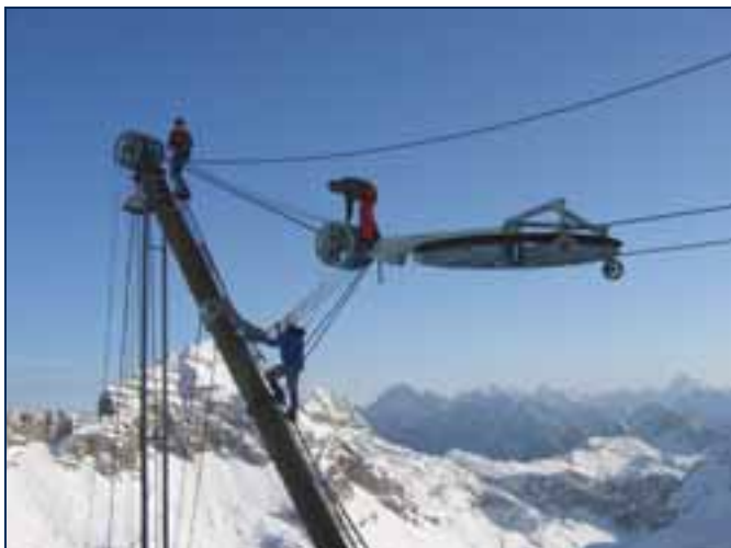
Zamenjava napenjalne vrvi in kontrola ležajev in osov in dvosedežnice Sedlo na Kaninu
