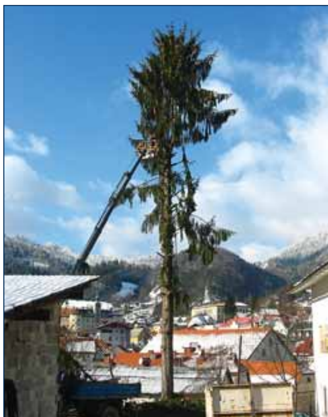
Vertikalni posek drevja v urbanem okolju zaradi bližine stavb ali komunikacijskih in energetskih vodov, tokrat pred Komunalo v Idriji
