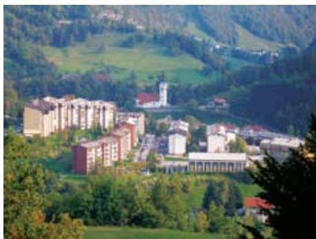
Koreja bo prav kmalu postala gradbišče, nato pa lepa in urejena soseka
