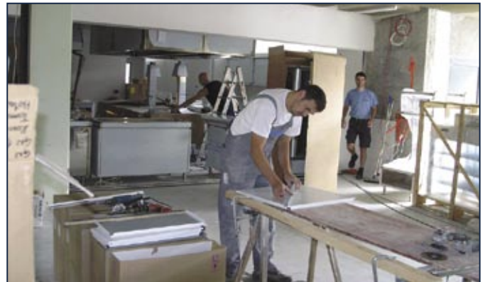
Zaključna dela so v polnem teku.
