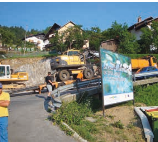
Hrup teže gradbene mehanizacije, prah, omejitve gibanja – potrpeti je treba, da bo nekoč boljše
