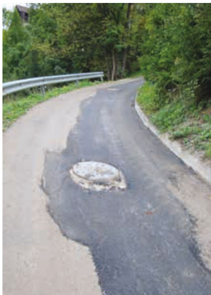
Taka je vmesna faza cestišča, ki čaka na nov asfalt
