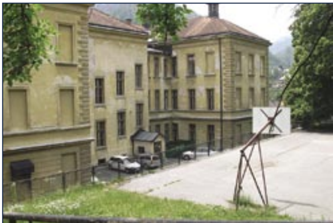
Pred začetkom obnovitvenih del in gradnje nove telovadnice za gimnazijo
