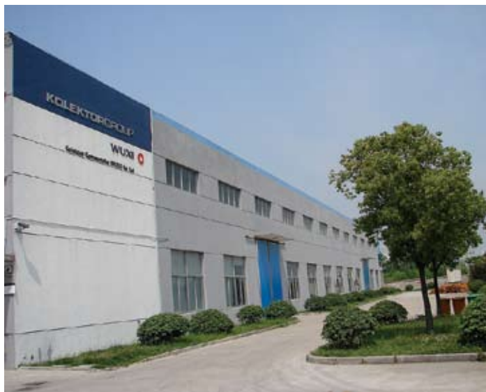
Proizvodno poslojje Kolektor Commutator (Wuxi)
