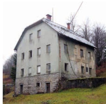
Objektu stare šole na Vojskem so šteti dnevi
