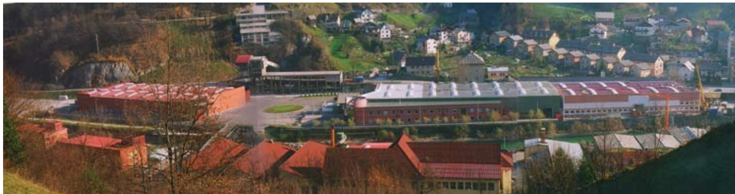
Pogled na Kolektorjevo industrijsko cono aprila leta 1999. Danes se je okolica nad njo že tako zarasla, da fotografije z gradnjo Razvojno-tržnega centra z istega mesta ni mogoče več posneti
