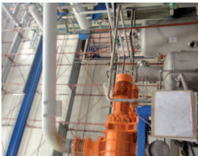
Peč za sušenje velikih transformatorjev je tako velika, da je med montažo nismo mogli ujeti v objektiv
