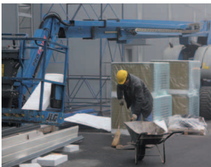
Zdaj se pa vidi, da so z deli na koncu. Asfaltaciji okolice je sledilo pometanje in pospravljanje
