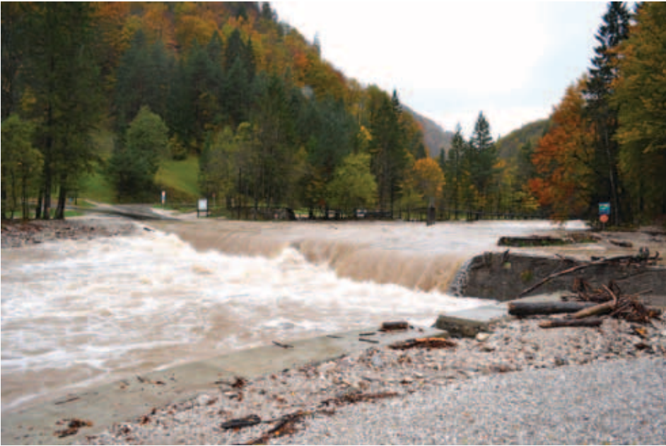
Prvi val padavin je največ škode povzročil na Lajštu
