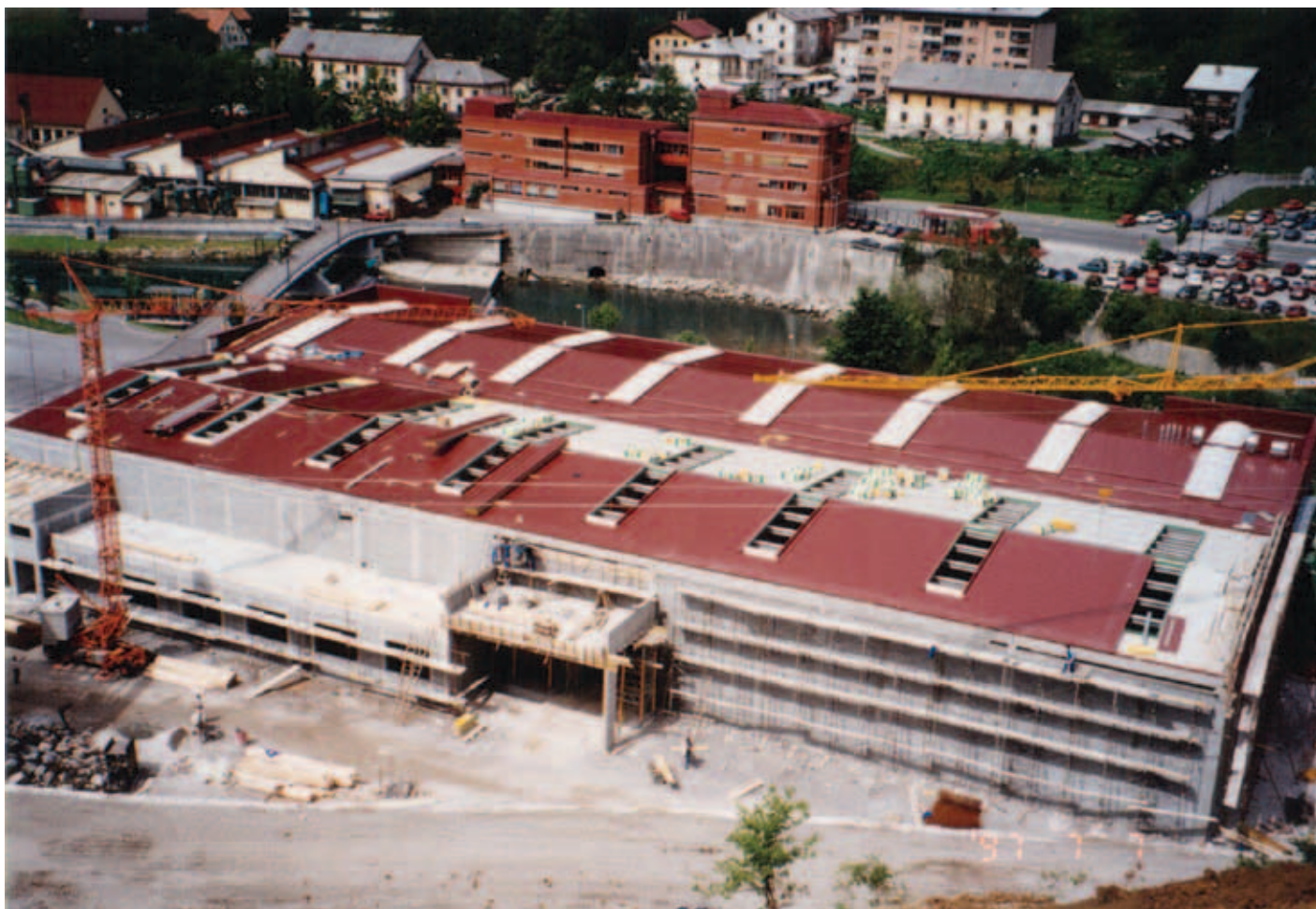
Gradnja še ene proizvodne hale na desnem bregu Idrijice
