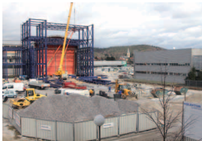
Prvi jekleni stebri hale
