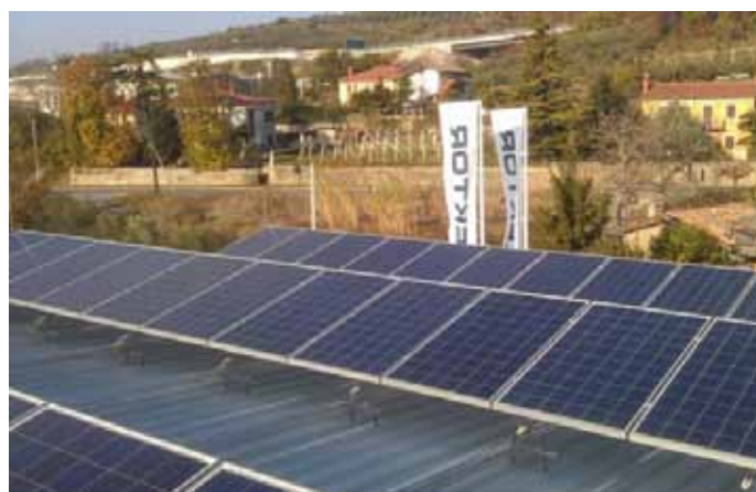
Sončna elektrarna na strehi proizvodne hale Kolektor Dekani, skupne moči 49 kWp. V elektrarni je vgrajen sistem daljinskega nadzora za dnevni nadzor delovanja in proizvodnje elektrike iz oddaljene lokacije, v tem primeru iz Idrije. Letno bo elektrarna proizvedla približno 60.000 kWh električne energije in prihranila 30 t izpustov CO 2 v ozračje
