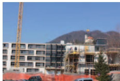
➤ Čeprav so zaradi mraza gradbinci za štirinajst dni zapustili gradbišče, v FMR zagotavljajo, da zamude ne bo
