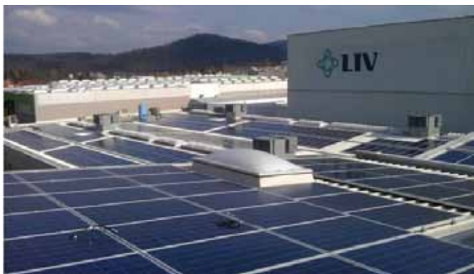
Sončna elektrarna na strehi Kolektorja Liv v Postojni. Gre za trenutno najzahtevnejši projekt, saj obsega preko 2600 solarnih modulov in kar 29 razsmerniških enot. Skupna moč te sončne elektrarne je 600 kWp
