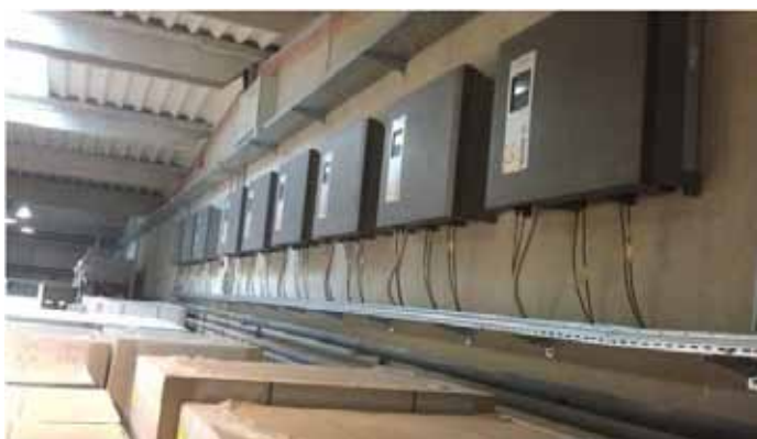
Razsmerniške enote. Naloga razsmernikov je pretvarjanje enosmernega toka, ki ga proizvedejo fotovoltaične celice v modulih, v izmeničnega. Koling uporablja razsmernike nemškega partnerja DIEHL Ako, ki slovi po zelo kakovostnih in visoko učinkovitih napravah
