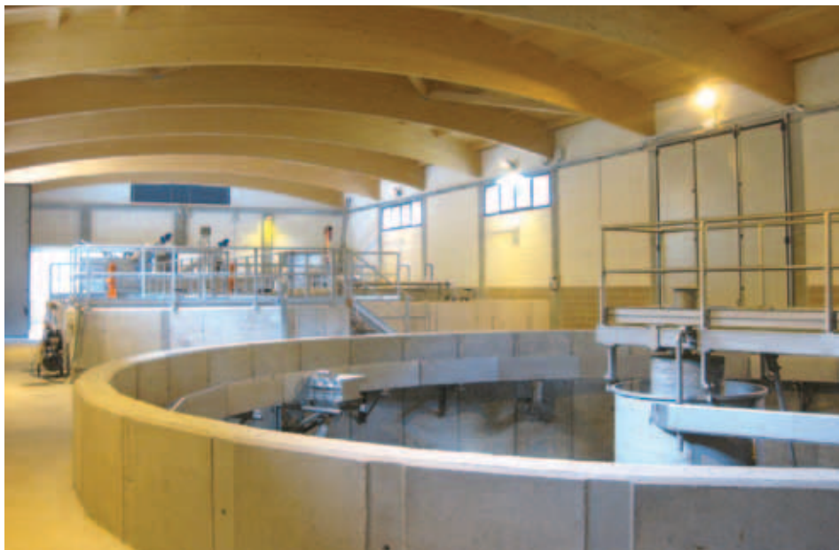
Čistilna naprava Brescia med gradnjo
