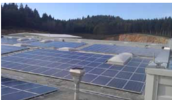
Sončna elektrarna na strehi podjetja Alpod v Podkrajniku, skupne moči 352 kWp
