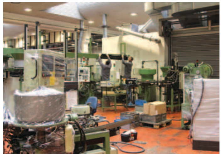
Demontaža starih linij proizvodnje komutatorjev za zaganjalnike, ki je že postavljena v Laktaših
