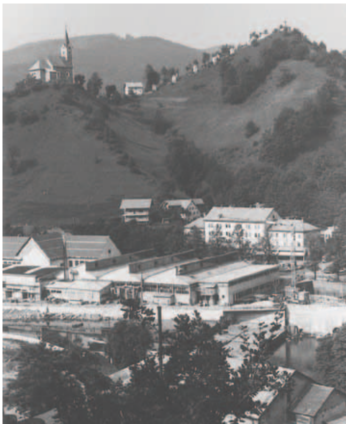
Pogled na nekdanji Kolektor izpod rudniškega dimnika
