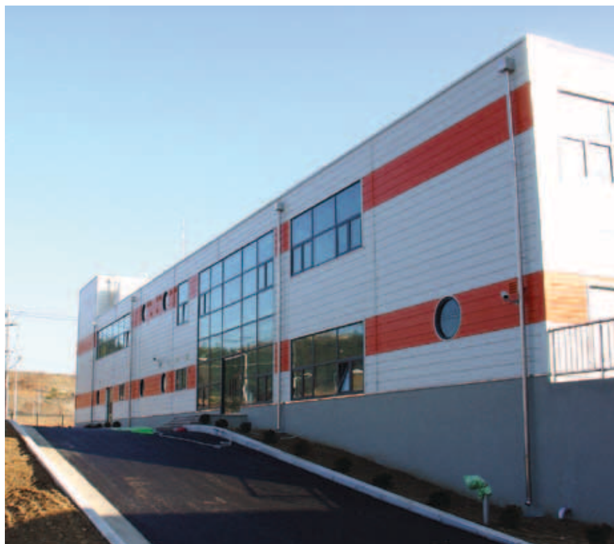
Kolektorjeva proizvodna hala v Južni Koreji, ki je lani dobila novo podobo
