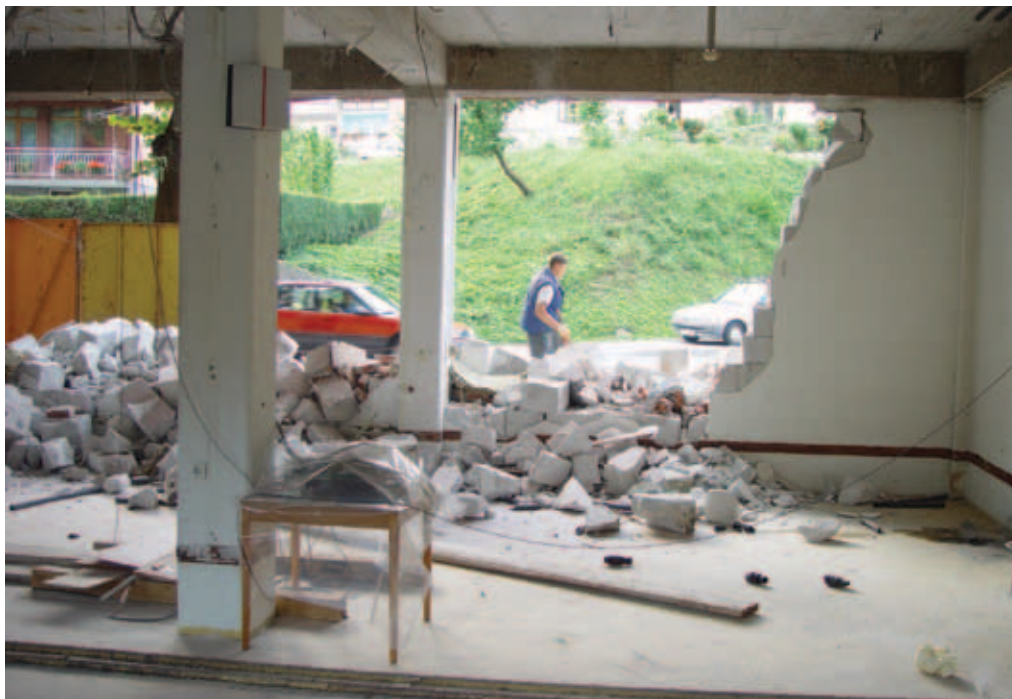
Prenova pritličja Kolektorjeve poslovne stavbe, ki je bila že zdavnaj zamortizirana in nujno potrebna adaptacije
