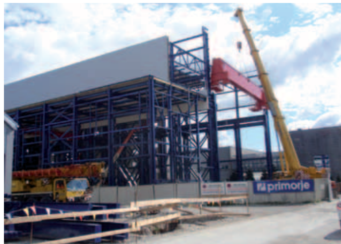
Eden od nosilcev najtežjega dvigala, ki je tudi eden redkih pri nas s tolikšno nosilnostjo, bo vsak hip na svojem mestu. Z njim je namreč mogoče dvigniti do 320 ton težak energetski transformator
