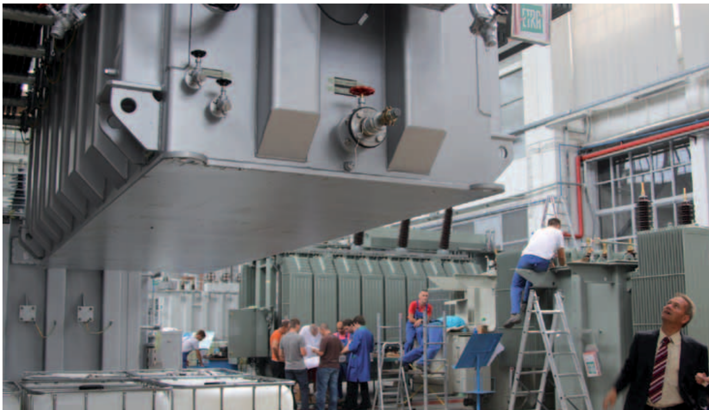
V novi hali se jim ne bo treba več tako stiskati kot v obstoječih. Ko bodo v njej delali s polno zmogljivostjo, bodo lahko na leto izdelali do 15 energetskih transformatorjev
