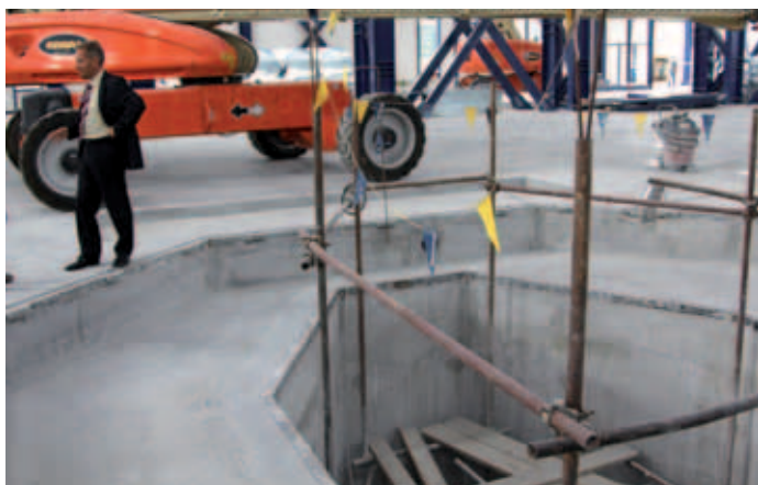
Glavni direktor Kolektor Etre dr. Tomaž Kmecl pred betonsko jamo za navijanje največjih energetskih transformatorjev
