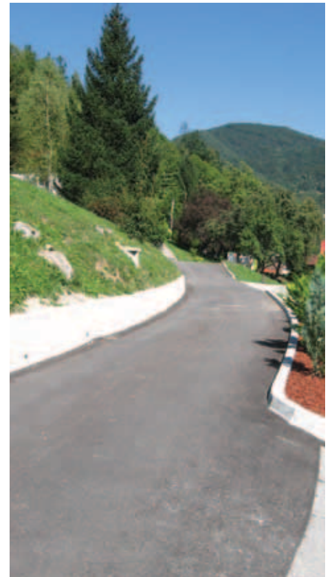
Z novim vodovodom so prebivalci Apurna dobili še lepo urejeno cesto z novo asfaltno prevleko, novimi robniki in podpornimi zidovi
