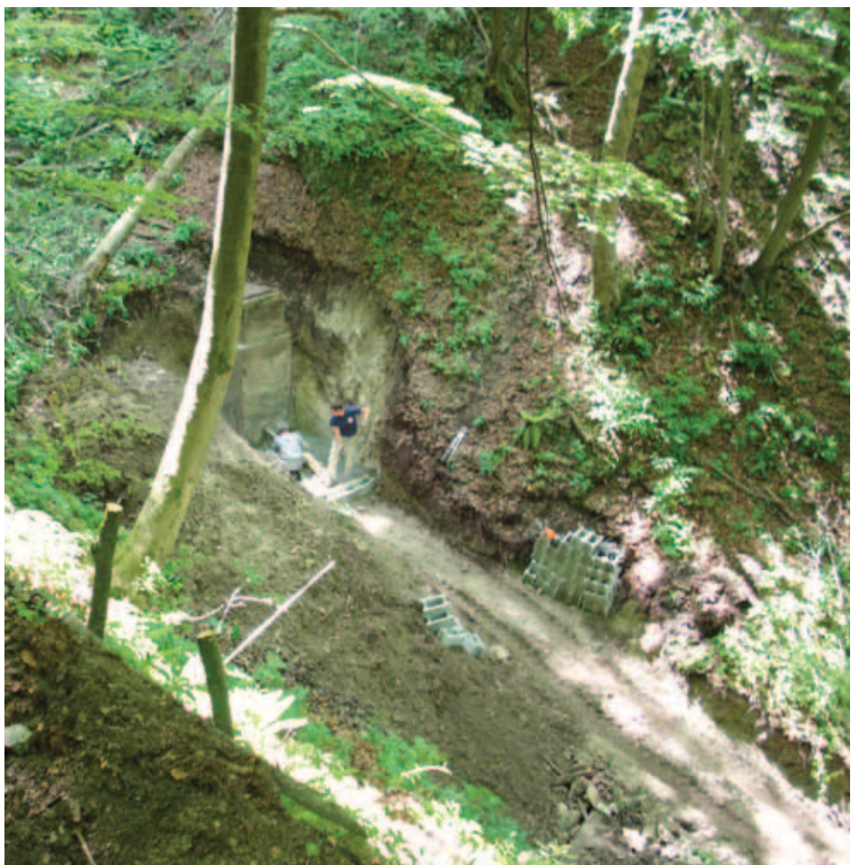
Sanacija zbirnega jaška Lepejžarce
