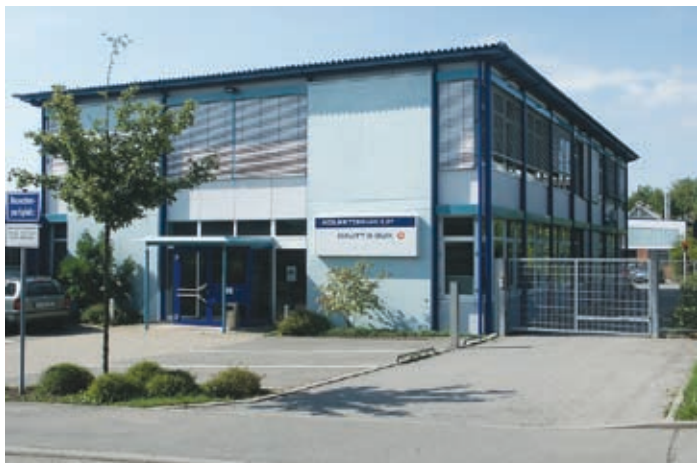
Upravna stavba Kautt & Buxa
